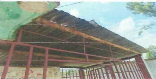
Foto 3: Cubierta y estructura de lámina área de chorros
