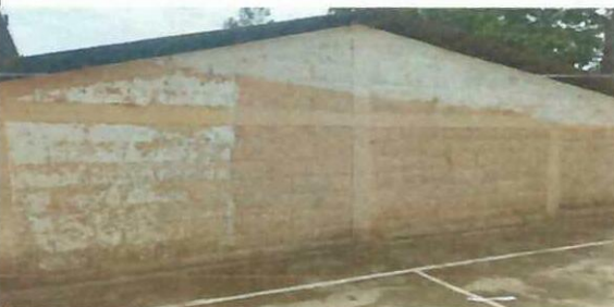
Foto 5: Pintura de muro de aulas módulo 2
