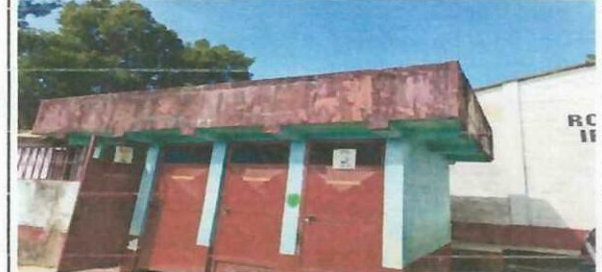
Foto 6: Pintura área de baños
