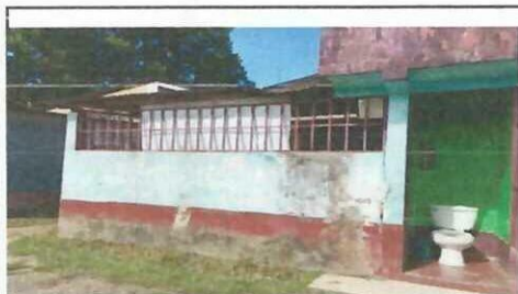
Foto 7: Muro frontal del baños
