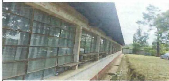
Foto 4: Canales, bajadas y drenaje de aguas pluviales
